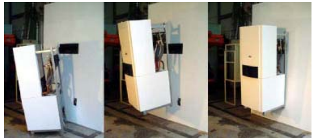
Fig. 06 Anschluß von Haustherme mittels standardisierter Schnittstellen
