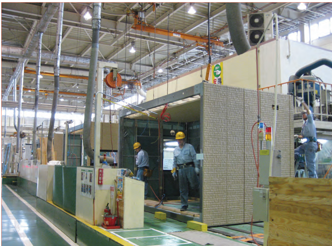
Bild 4: Individueller Ausbau eines Gebäudemoduls auf dem Fließband, Sekisui Heim.
